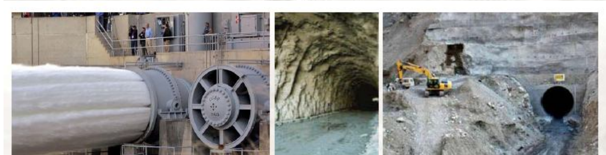
شکل ۱۴: نمایی از تونل های انحراف در سدهای خاکی
