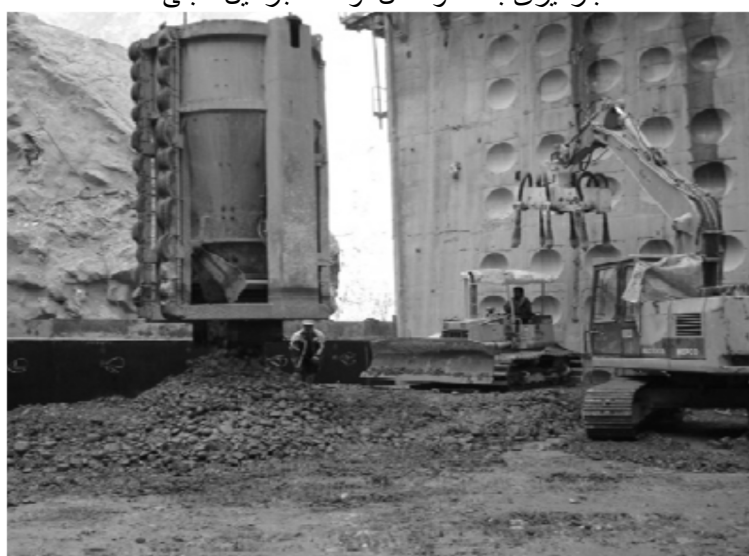
تخلیه باکت روی مقطع
