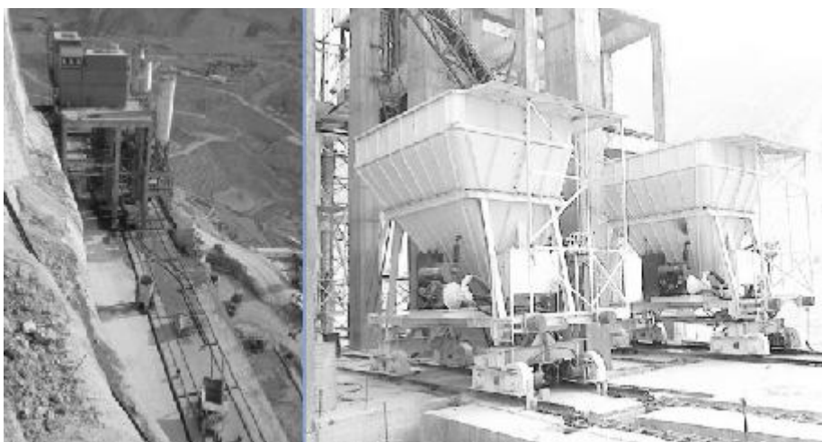
بتن از بچینگ به محل بارگیری توسط سیلو باس
